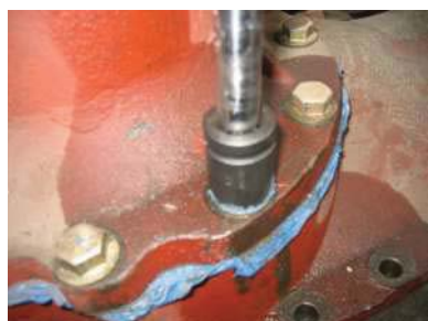
Снятие корпуса подшипников
